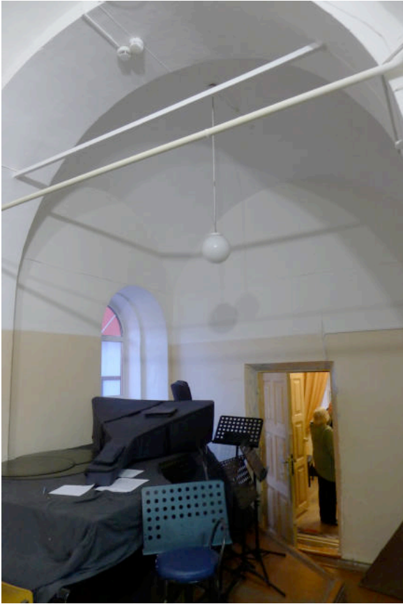
Фото 26. Северная часть алтаря.
