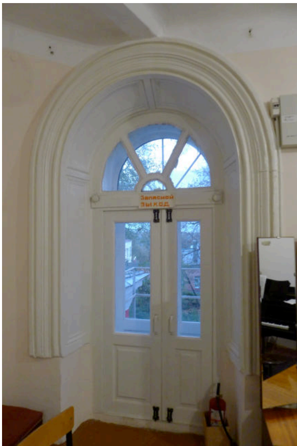
Фото 31. Верхнее окно южной стены, преобразованное в дверной проем.
