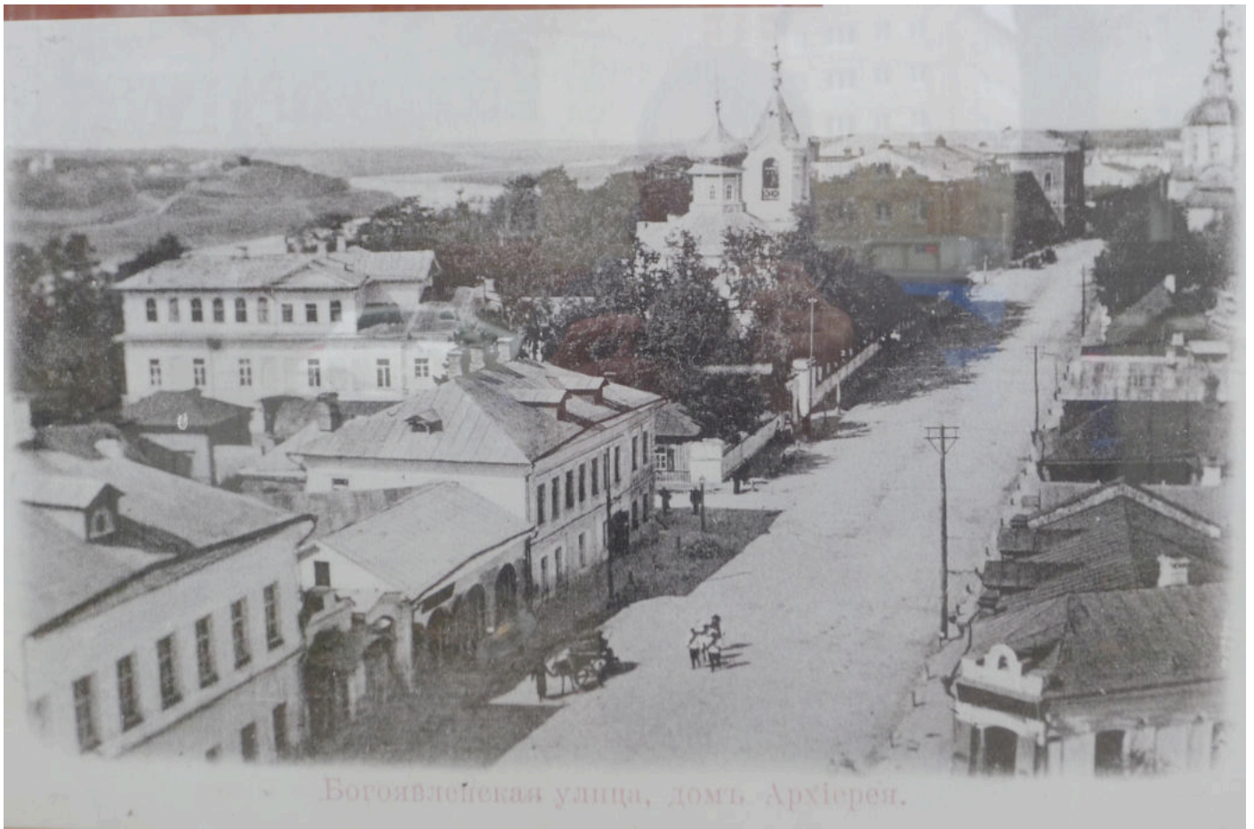
Фото 2. Здание домовй церкви и певческой школы (в середине кадра). 1900-е гг.
