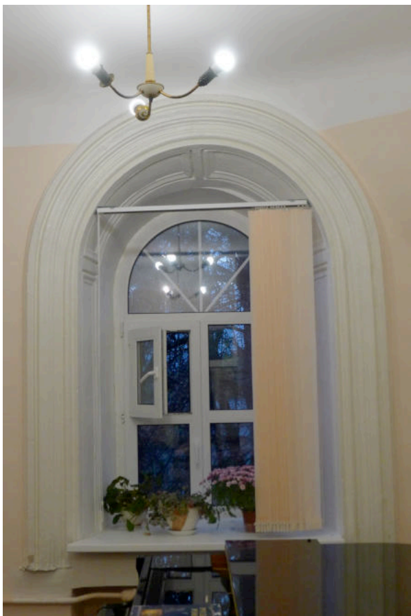
Фото 30. Обрамление верхнего окна южной стены.
