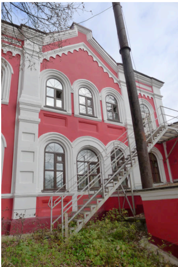
Фото 18. Южный фасад храма.
