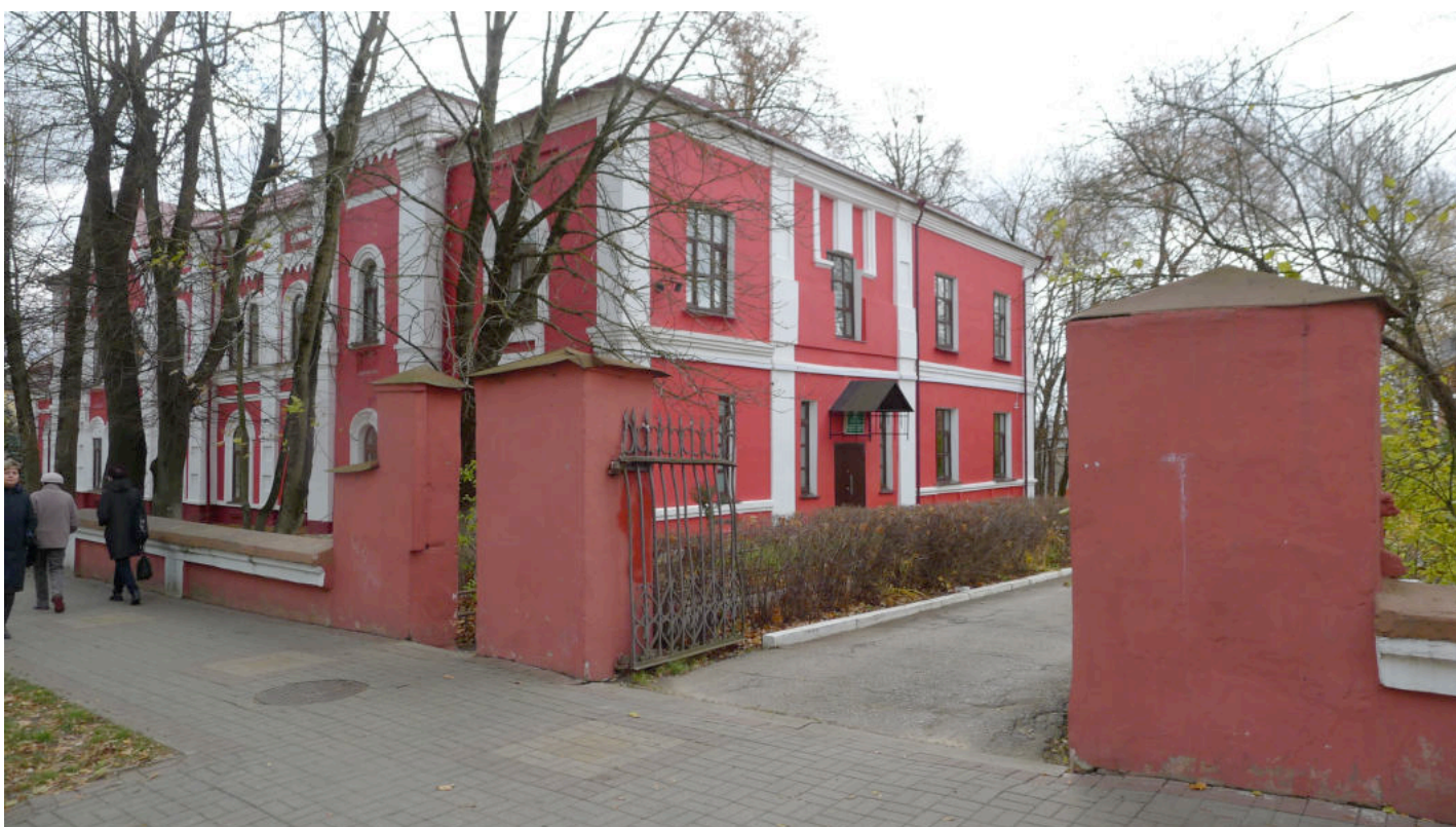
Фото 9. Вид здания с северо-запада.
