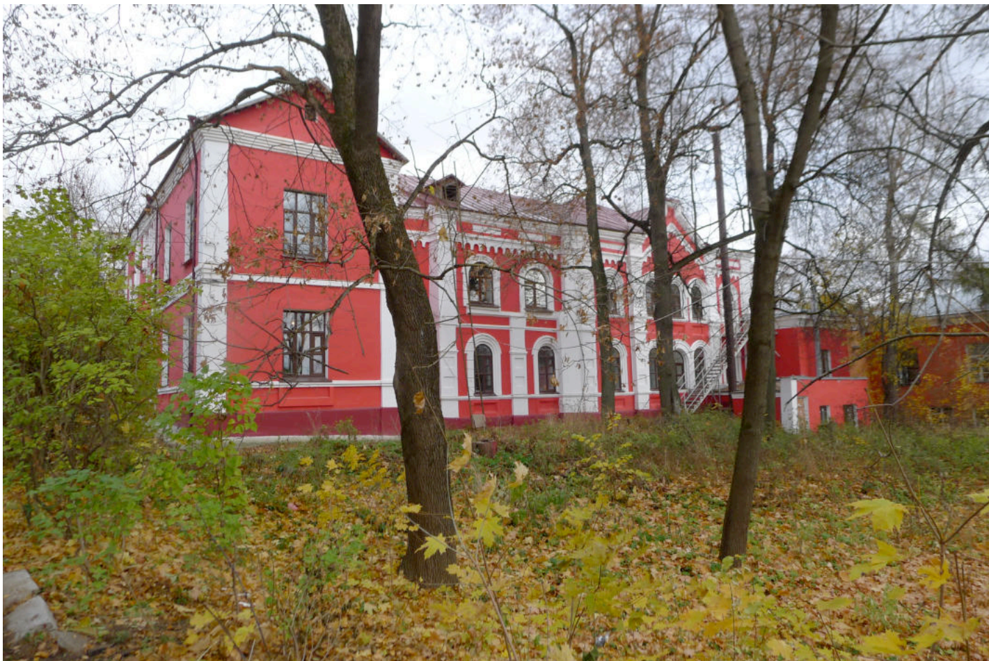
Фото 10. Вид здания с юго-запада.
