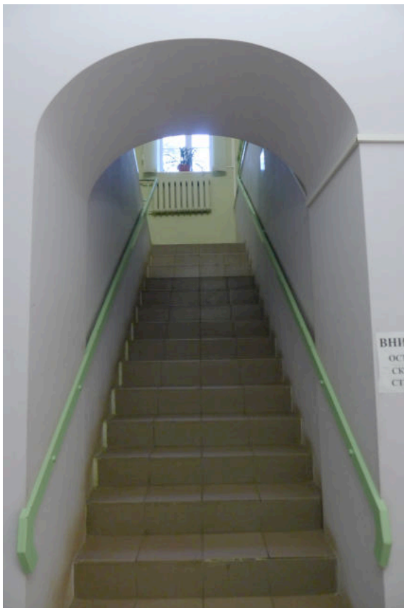
Фото 29. Лестница на 2-й этаж в северной пристройке к колокольне.
