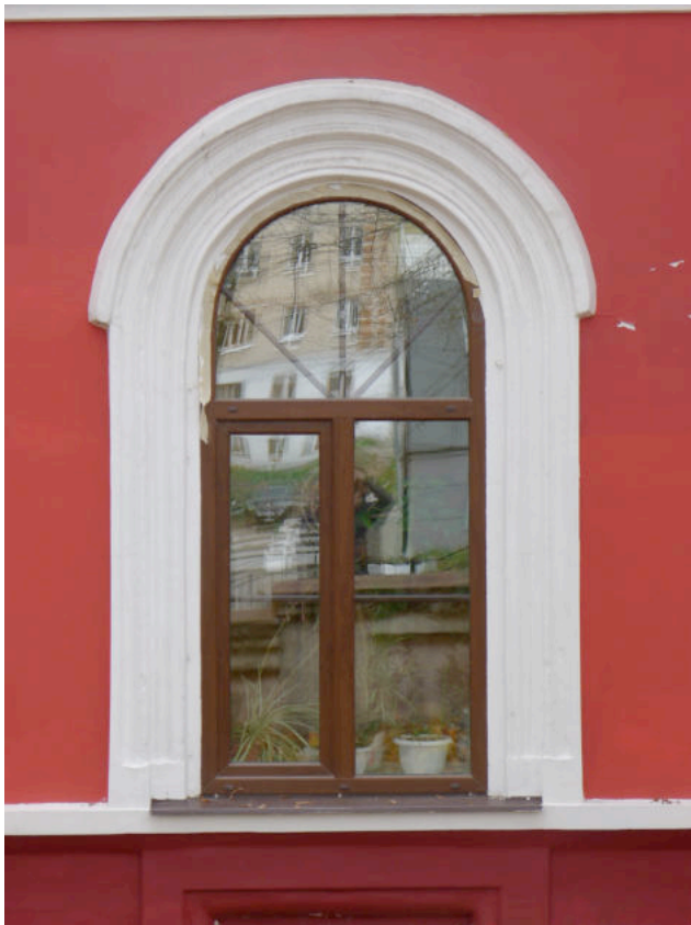
Фото 14. Наличник на северном фасаде.
